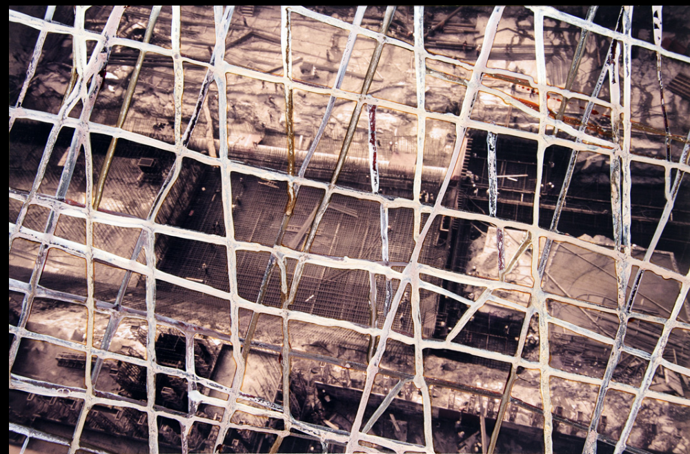
[DA SÉRIE] CANTEIRO DE OBRAS 2006 backlight 60 x 90 cm
